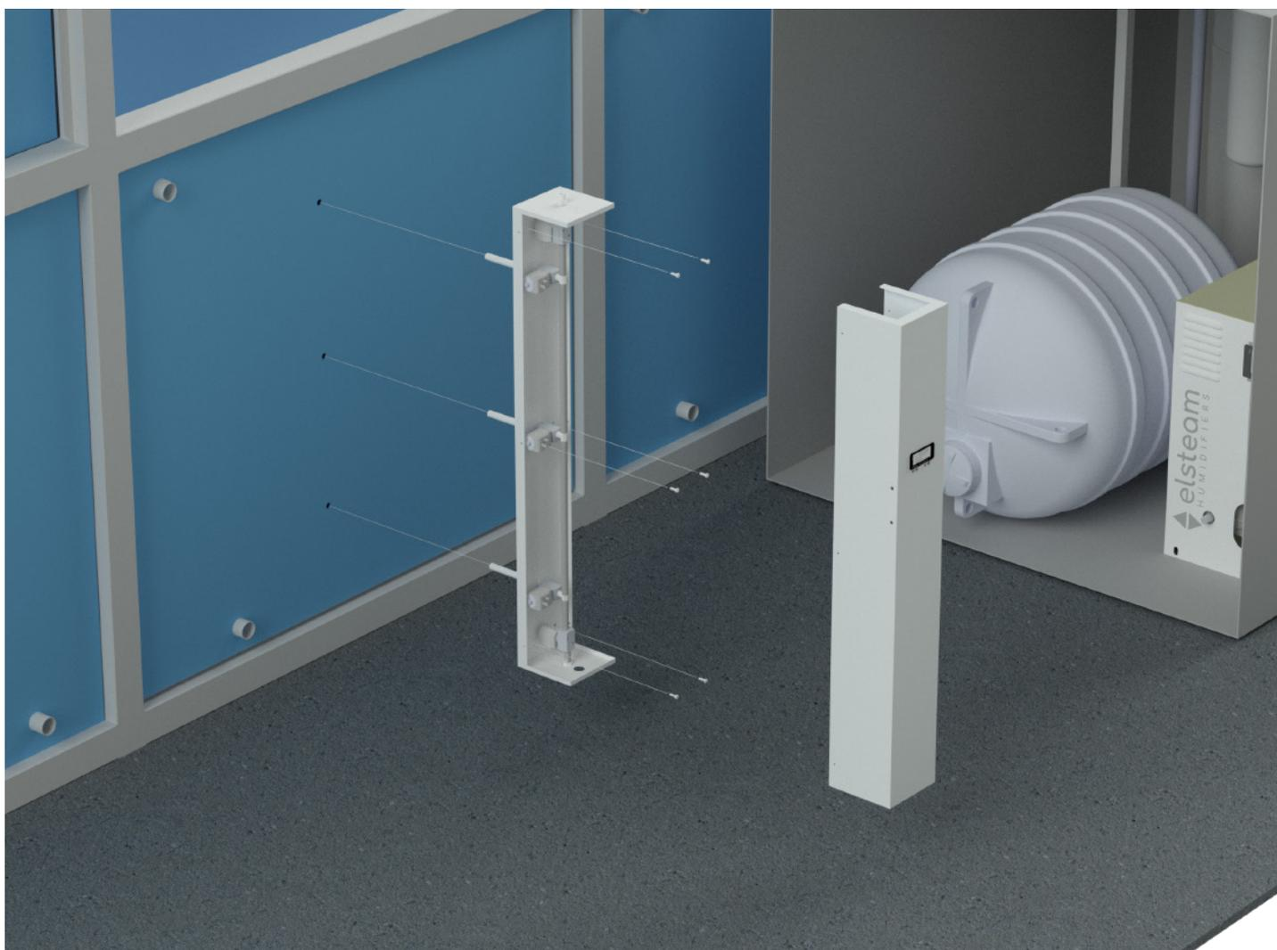
**Fig. 12.** Montaje del rack de distribución
